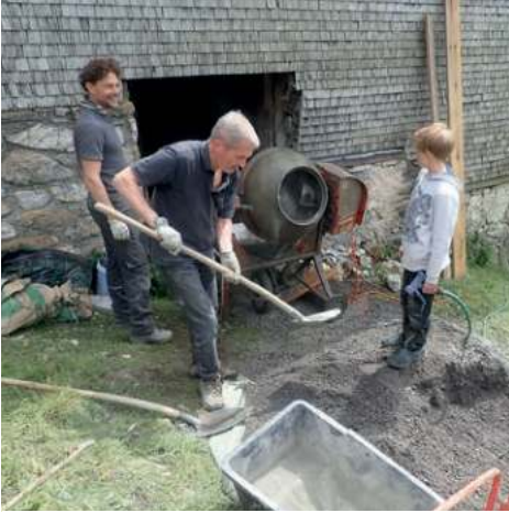
Beton zubereiten
