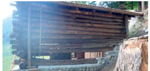
Sanierung Tschüggelistall kurz vor Fertigstellung
