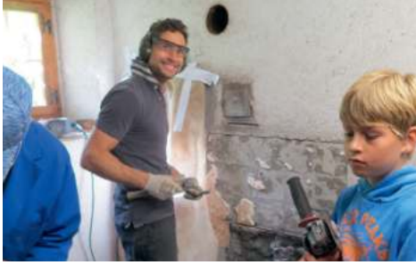
Küchensanierung im Guschaheim mit Andi und Junior
