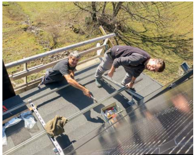
Montage der Fotovoltaik-Anlage
