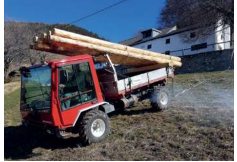
Rundholztransport für Sanierung Tolenborthaus
