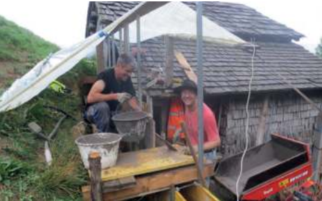
Auch bei Regen wird gemauert
