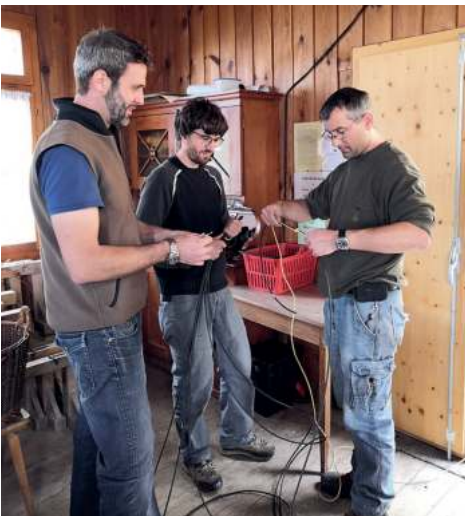
Das Säli wird elektrifiziert
