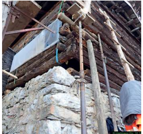
Sanierung am Tschüggelistall
