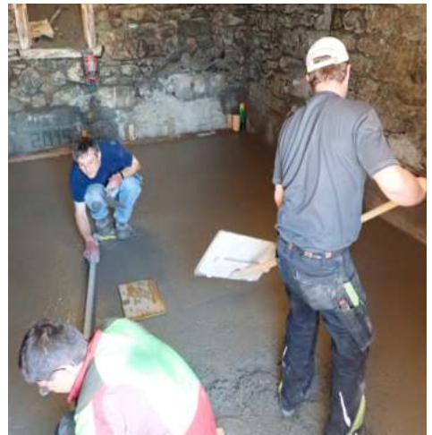
Fertigungsarbeiten im ehemaligen Brunnenhausstall
