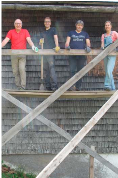
Rotarier Bad Ragaz entfernen alte Schindeln
