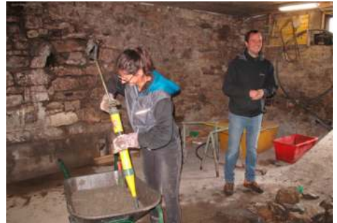
Ein freiwilliges Ingenieurteam bei Maueranierung
