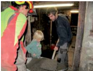
Mauerunterfangen im Magazin
