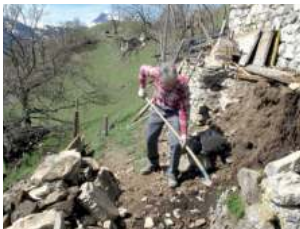
Stützmauersanierung durch Thomas Bähler
