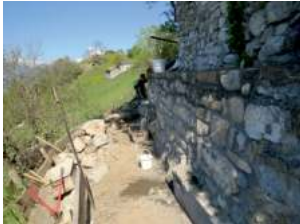
Stützmauer Säli vor Fertigstellung
