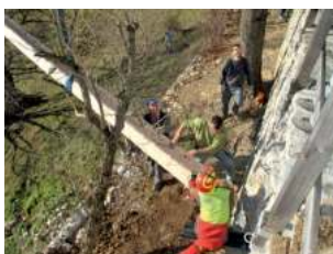
Holzkänneinsatz wird eingesetzt
