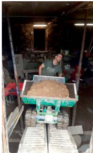
Rolf beim Aushubtransport
