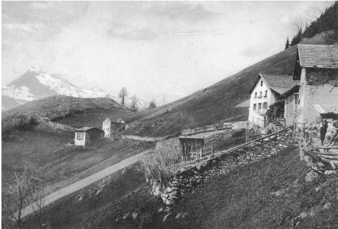
Guscha vor 1900. Nach der grossen Auswanderungswelle im 19. Jahrhundert zerfielen die Wohnhäuser der Walsersiedlung
