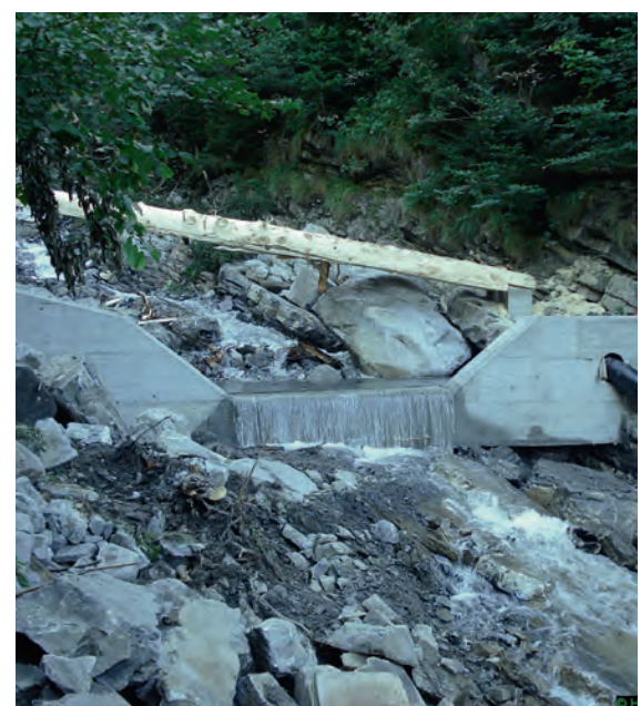
Neue Wasserfassung im Guschnertobel (Bild Verein Pro Guscha)
