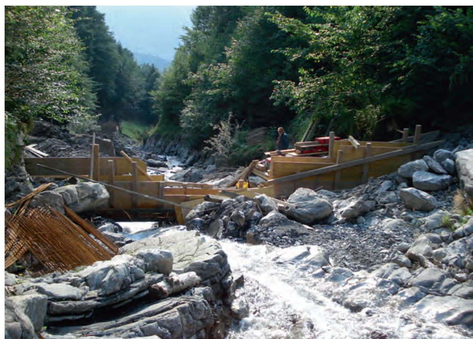
Neue Fassung im Bau (Bild Verein Pro Guscha)
