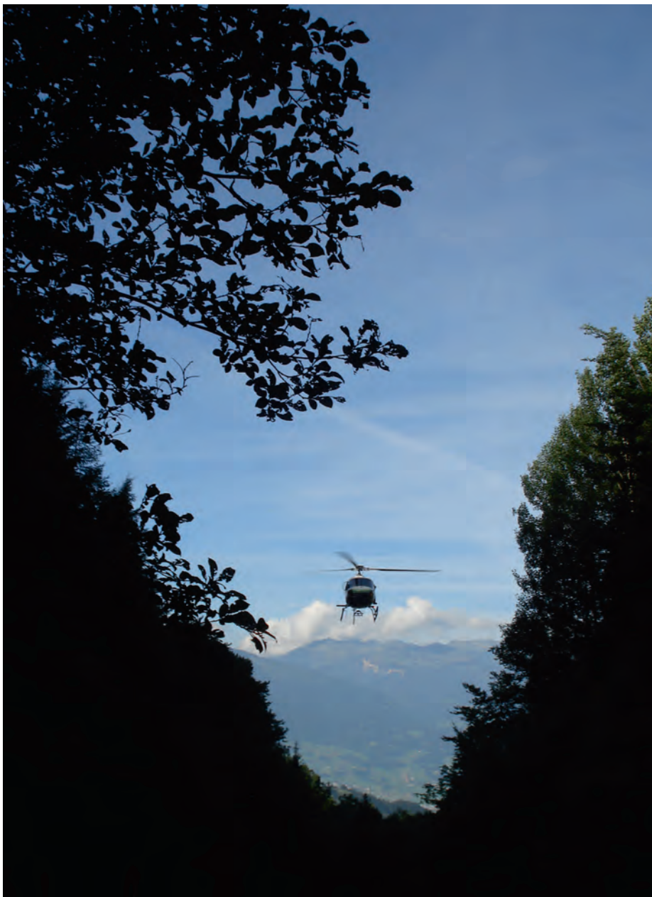
Betontransport für die Fassung im Guschnertobel mit Helikopter der Air Grischa (Bild Verein Pro Guscha)
