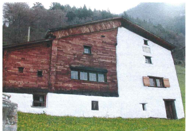
Schulhaus nach der Sanierung.
