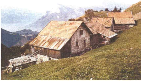
Guscha vor der Sanierung, ca. 1960. Bild rechts: Guscha nach der Sanierung, die 1973 in Angriff genommen wurde.
