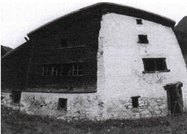
Schulhaus vor der Sanierung.
