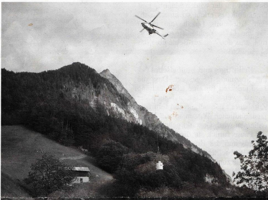
Für den Transport der 3,2 Tonnen schweren Brunnenstube von der St. Luzisteig auf die Guscha musste der Superpuma aufgeboden werden.
